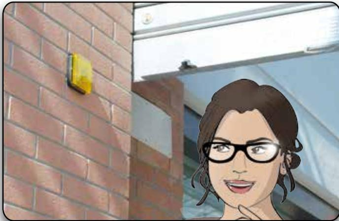
Il lampeggiatore a LED ALF6 è la soluzione da parete per una installazione semplice e gradevole. L'alimentazione multitensione (12/24/230V) ne permette l'utilizzo con tutte le centraline di comando in commercio grazie anche al Jumper di selezione del lampeggio.
