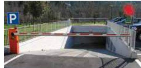
Gracias a la pantalla LCD, la unidad de control puede programarse fácilmente según una de las 3 lógicas de funcionamiento: controlada por tiempo, controlada por reserva o lógica mixta.
